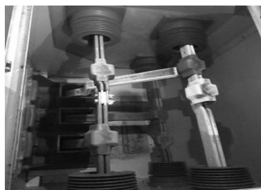
图5 开关柜母线仓结构图
